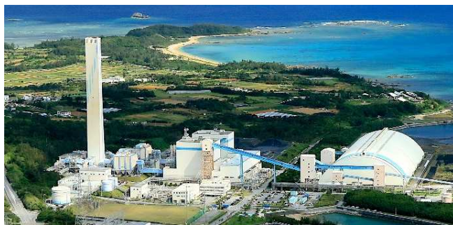
金武火力発電所
